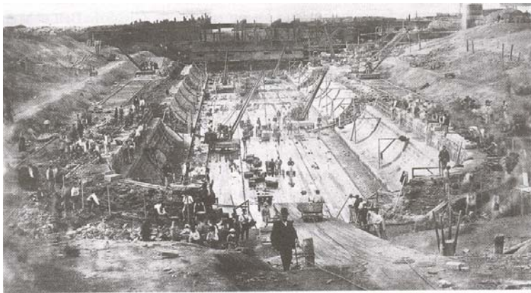
Obras del dique 1.877
